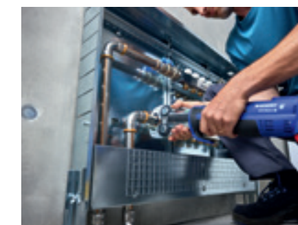
Dovedit de miliarde de ori: Geberit Mapress Therm funcționează la fel ca orice alt sistem Mapress. Nu sunt necesare instrumente noi.
