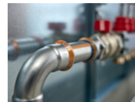
Marcarea suplimentară cu semnul de avertizare "apă nepotabilă".
