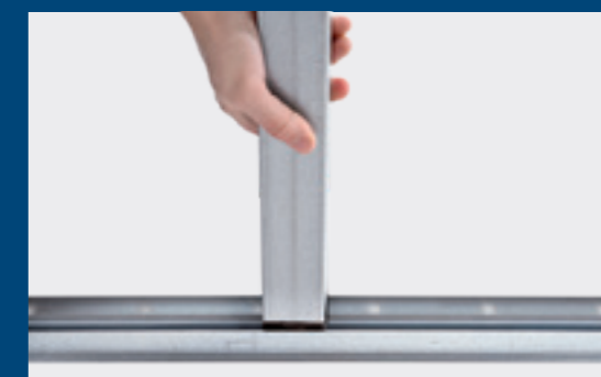
↑ Înșurubați prezoanele Geberit Duofix în șina de pe tavan și trageți extensia telescopică în jos.
